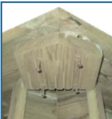
Fixation de la plaque sous margelles.
