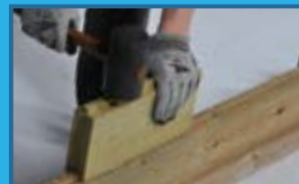
À l'aide d'un maillet, frappez sur la cale en bois pour emboîter à fond les madriers.
