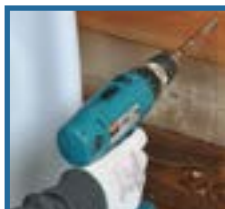
Fixez les consoles avec les vis de 6 x 90 (1 vis par madrier)
