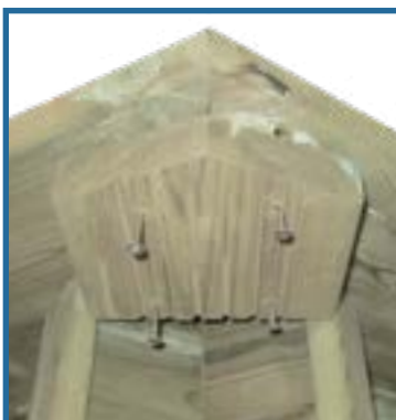
Fixation de la plaque sous margelles.
