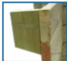
Alignez la console au sommet du madrier.
