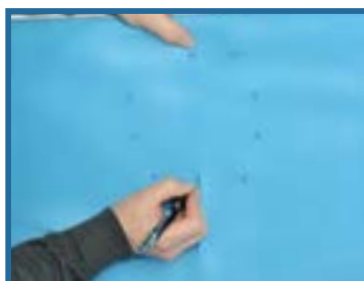
Repérez et tracez l'emplacement des vis.
