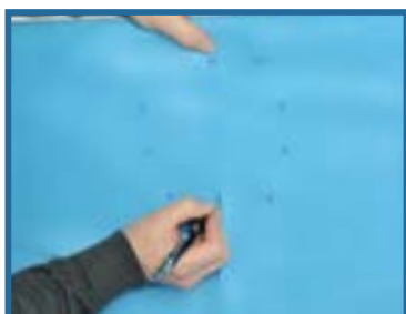
Repérez et tracez l'emplacement des vis.
