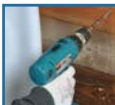
Fixez les consoles avec les vis de 6 x 90 (1 vis par madrier)
