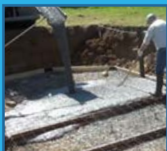
Réalisation de la dalle béton
