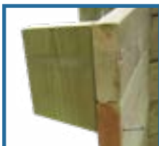
Alignez la console au sommet du madrier.
