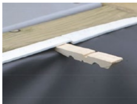
Figure 31 – Verrouillage du liner grâce à des demi-épingles à linge
