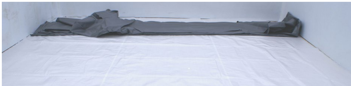
Figure 32 – Dépliage du liner
