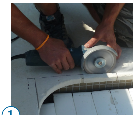
Découpe de la margelle pour donner la forme d'un angle vif
