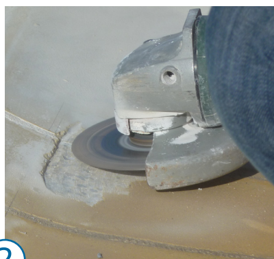
Surfaçage de la margelle pour avoir une surface plane
