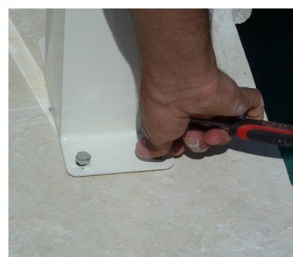
Fixation des plots support d'axe
