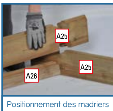
À l'aide d'un maillet, frappez sur la cale en bois pour emboîter à fond les madriers.
