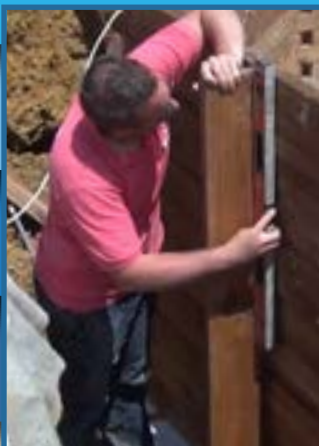
Contrôlez l'aplomb des renforts.
