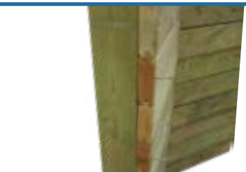
Assemblez le renfort en mettant une vis par madrier.
