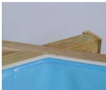
Tense the liner well at the corners Tense bien el liner en las esquinas Tendez bien le liner dans les angles
