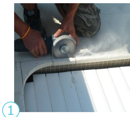
1 Découpe de la margelle pour donner la forme d'un angle vif
