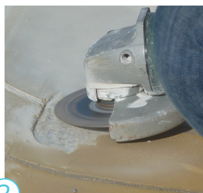
2 Surfaçage de la margelle pour avoir une surface plane
