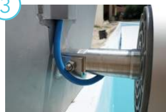
Faire remonter le câble moteur sous le carter le long du support moteur
