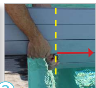
3 Faire glisser le module supérieur sur toute la largeur en tenant les 2 modules le plus droit possible
