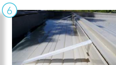
Une fois les lests en place, contrôler l'alignement des sangles et vérifier que la poutrelle soit de niveau
