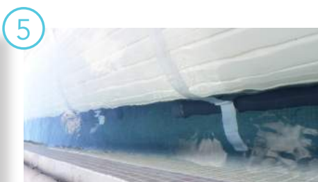
Régler la hauteur du lest tubulaire, il doit se trouver à 5cm environ du sol du bassin quand la couverture est déroulée
