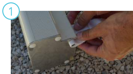
Glisser les sangles de contre-poids dans le profil poutrelle prévu à cet effet
