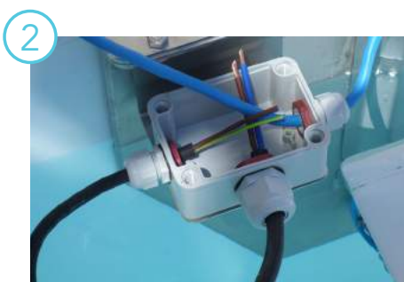
2 Raccorder le câble moteur (bleu) aux câbles tirés en utilisant les connecteurs fournis (voir schéma de raccordement p.20)
