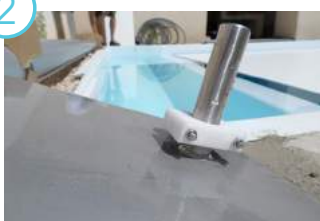
Mettre en place la bague de maintien sur le support sans la serrer
