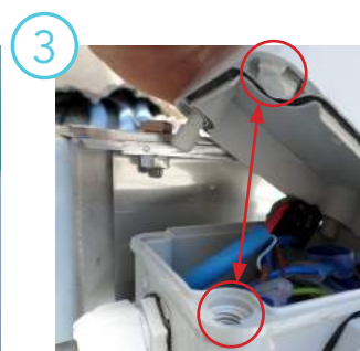
3 Refermer le boîtier en respectant l'encoche du détrompeur pour assurer l'étanchéité, puis serrer les presse étoupes. Une fois les fins de course validées, remplir de gel étanche (voir p.29)
