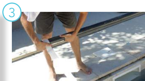
Passer les tubes de contre-poids dans leurs sangles
