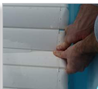
2 Donner un mouvement vers le haut puis vers le bas en gardant la position rapprochée
