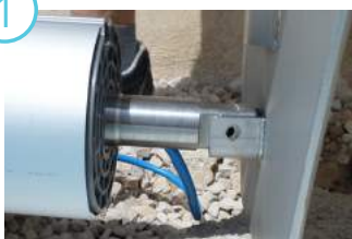
Présenter l'axe (côté moteur) sur le support moteur
