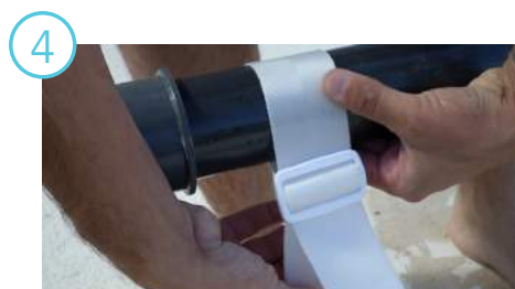
Serrer suffisamment la sangle de manière à maintenir le tube en place
